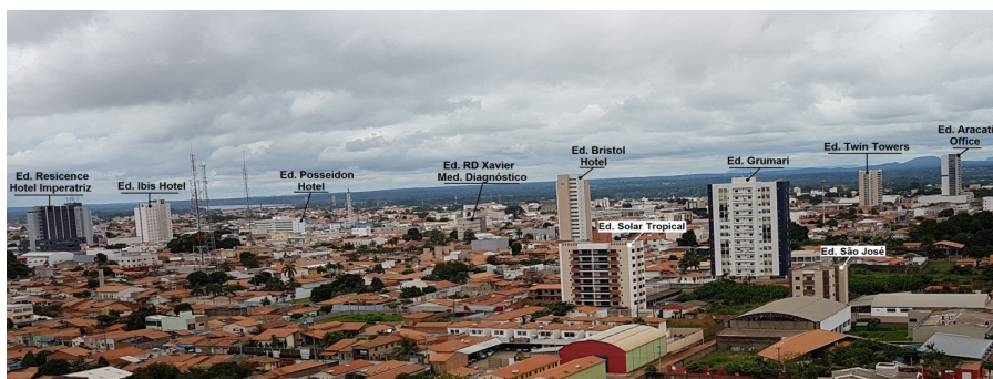
Figura 3 - Vista parcial do Centro de Imperatriz com detalhe dos edifícios mais altos. Fonte: Oliveira (2017).
