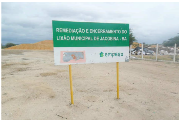
Figura 6 - Placa indicativa da obra de remediação do antigo lixão municipal para implantação do aterro controlado. Foto: Emille Menezes. Acervo pessoal.
