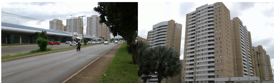
Figura 8 - Vista do condomínio que se destaca em toda a Região Administrativa. Fonte: Arquivo pessoal dos autores (2017).
