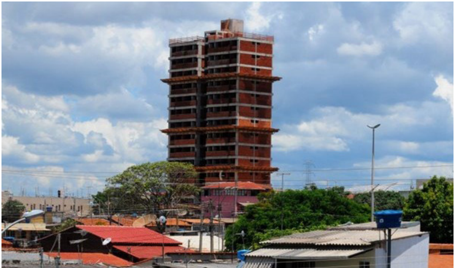
Figura 2 - Edifício em construção. Samambaia.
