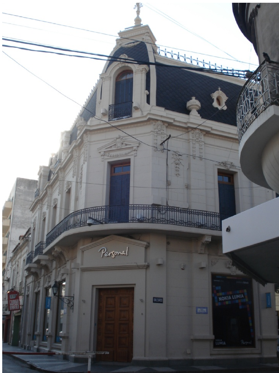
Foto 1 - Fachada pintada según la escala cromática definida en el PRAC con cartelería discreta
