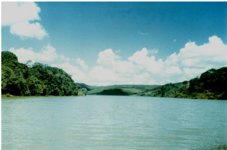
Figura 18 – Vista parcial da Barragem Brejão.
