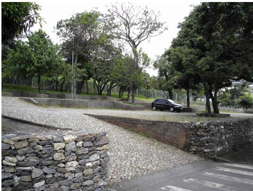
Figura 4. Aspecto da área de estacionamento. Destaque para o revestimento permeável e para a construção de platôs (fev/2007).
