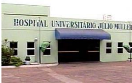
Figura: 02 - Faixada do Hospital Universitário Júlio Muller - UJUM
