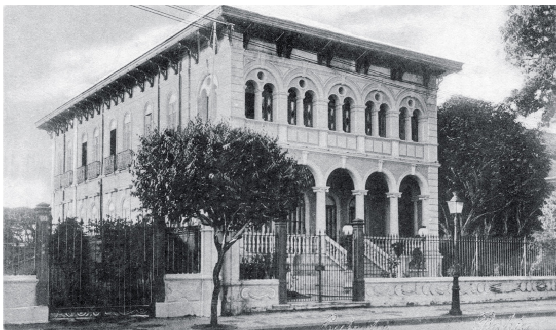
Figura 10: Segunda sede da Sociedade Euterpe (atual Solar Cunha Guedes) no Corredor da Vitória, em Salvador. Fonte: Fotografia de Almeida & Irmão (ca. 1924) 13
