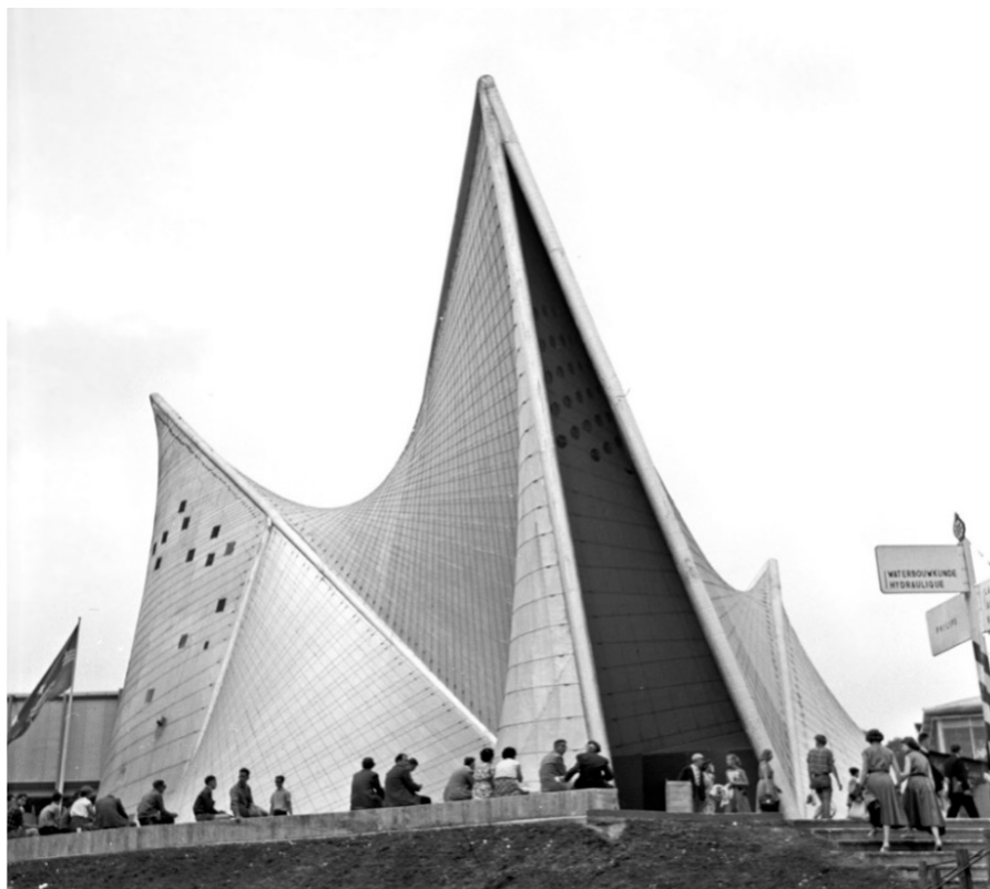
Figura 9. Pabellón Phillips en Bruselas. 1958.
