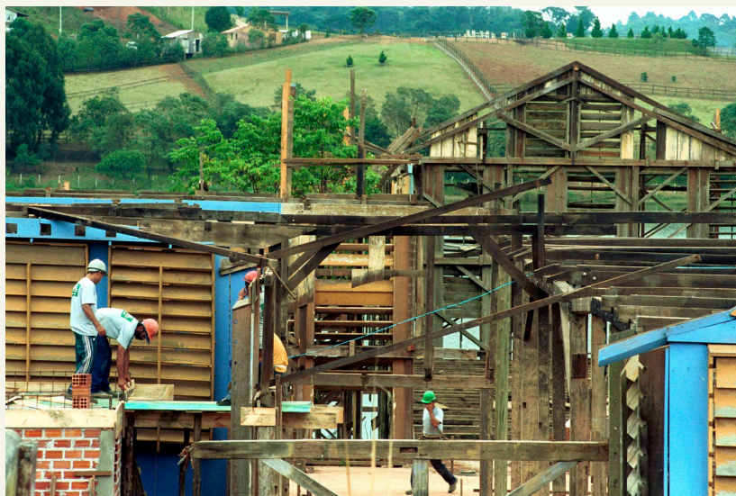
Figura 4. Espaço Design Passaúna, início da reforma.
