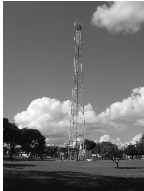
Foto 2 – Torre de metal em treliça Fonte: Tofeti, 2013.
