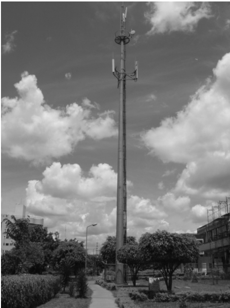
Foto 1 – Torre compacta de metal Fonte: Tofeti, 2013.
