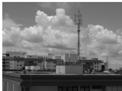
Foto 3 – Treliça de metal roof top
