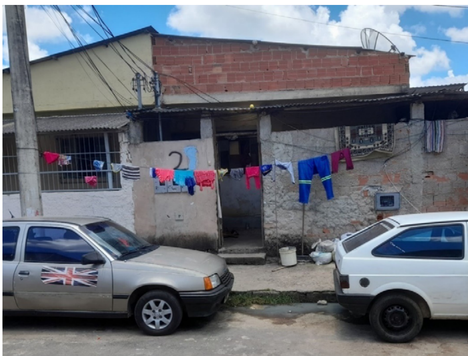
Figura 2: A arquitetura do Parque das Torres, fotografia do autor, 2022
