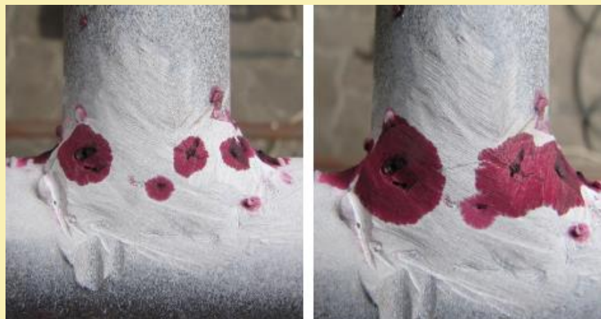
Figura 9 – Ensaio por líquido penetrante em cordões de solda em carros alegóricos
